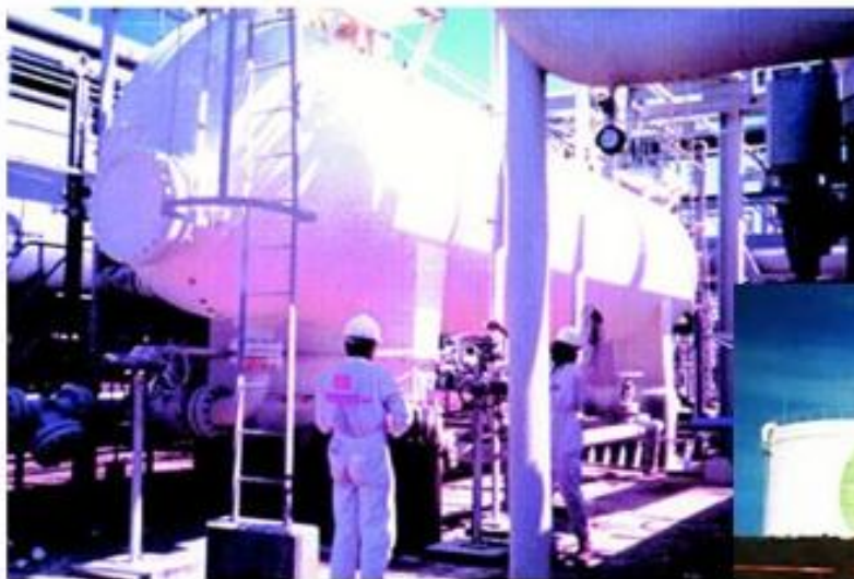
Cisteme di gas, Kuwait
